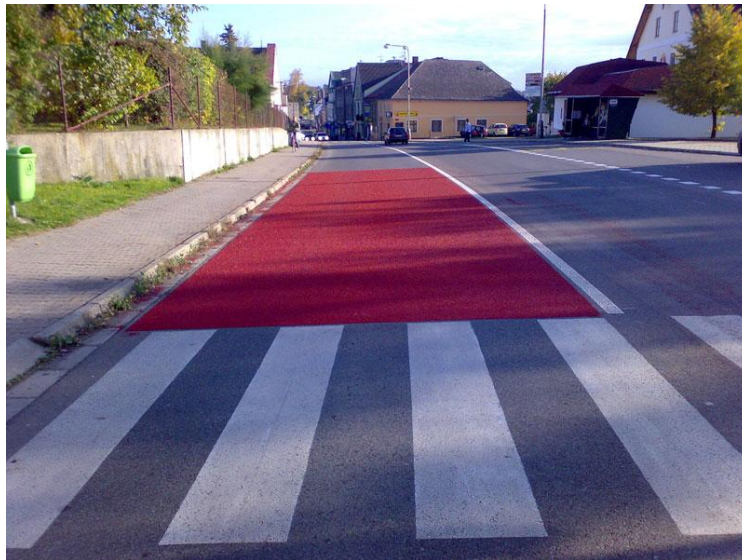
Obr. 31 – Ukázka bezpečnostní protismykové úpravy [23]
