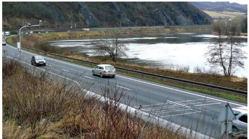
Obr. č. 26 – Instalace rychloměru se skládá z inteligentní kamery, infra reflektoru, infra blesku a indukčních smyček ve vozovce. Zdroj: [17]
