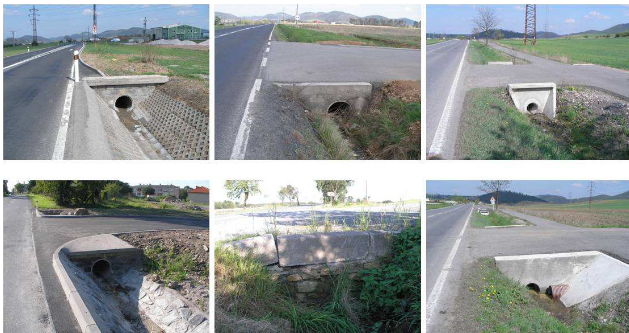
Obrázek 40 Konstrukce samostatných sjezdů v extraviľanu (přijezdy k firmám)
