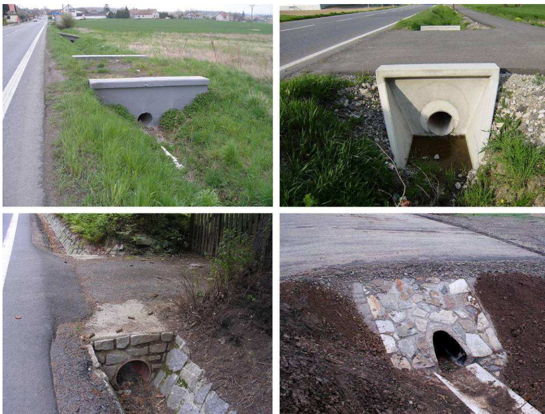
Obrázek 17 Konstruktivní řešení samostatných sjezdů
