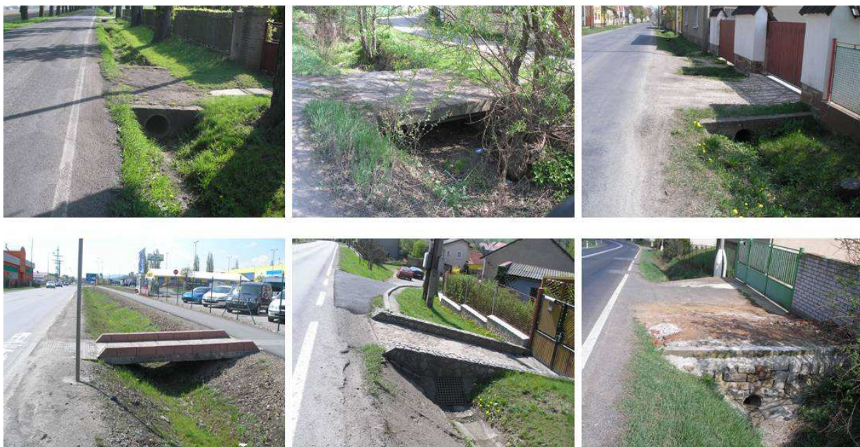
Obrázek 42 Konstrukce samostatných sjezdů v intraviľanu
