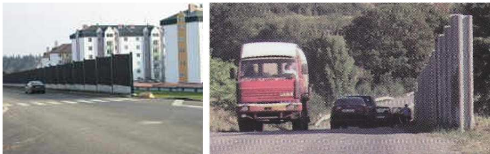
Obrázek 18 Nevhodné zakončení protihlukové clony [2]
