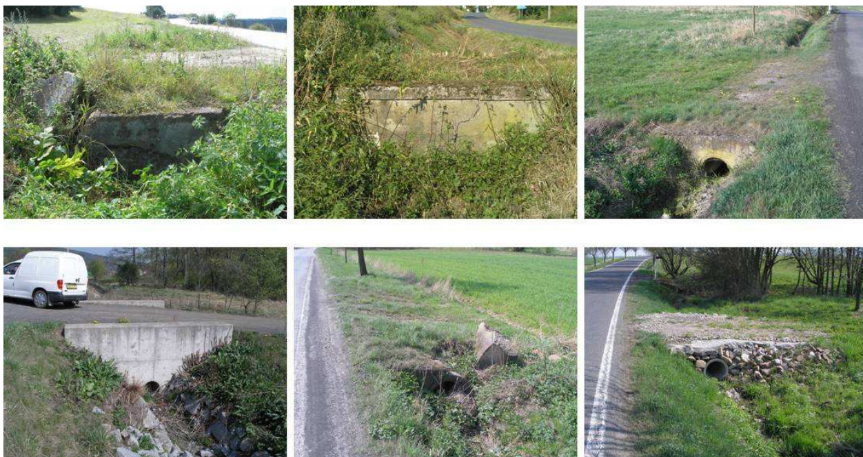
Obrázek 41 Konstrukce samostatných sjezdů v extraviľanu (zemědělské sjezdy)
