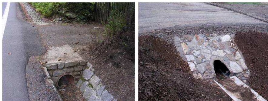
Obrázek 45 Příklad provedení kolmého a šikmého čela sjezdu
