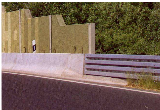
Obrázek 19 Ochrana protihlukové clony proti nárazu [2]
