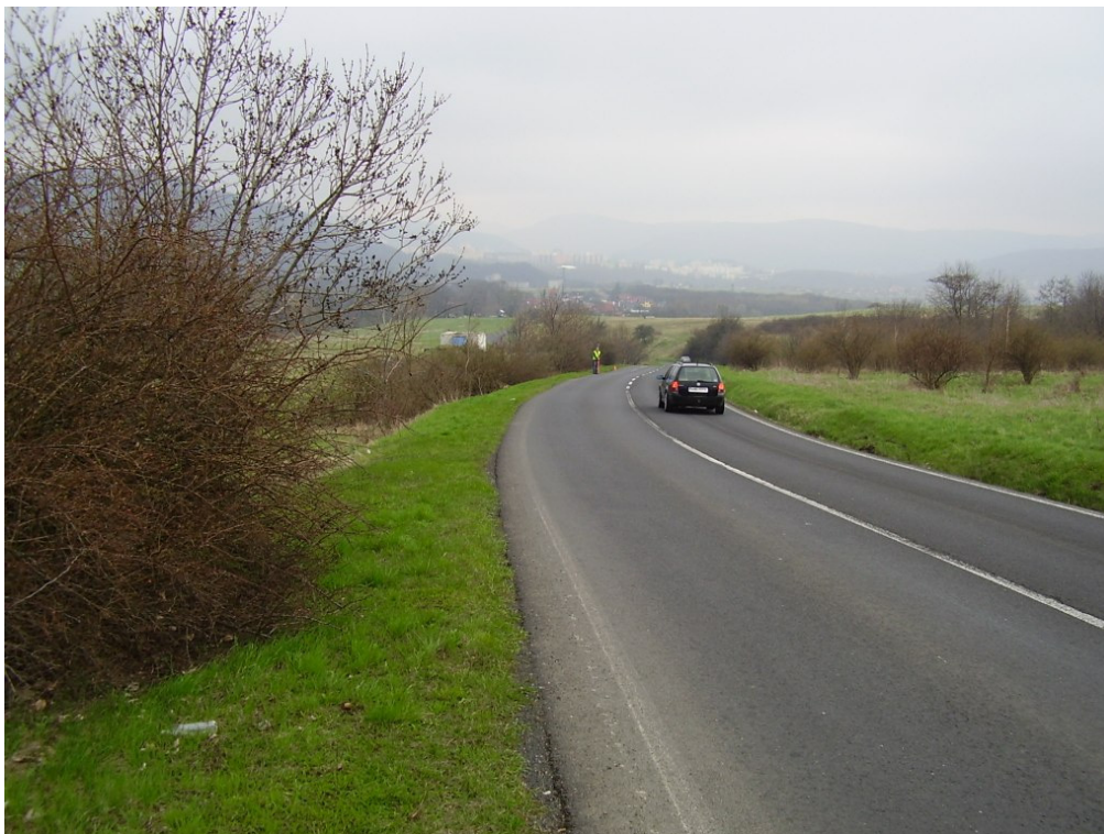
Obrázek 25 – Pohled směr Strážky; na fotografii je zachycena činnost vytyčování vnitřní části vodícího proužku; pozice za vrcholovým zakružovacím obloukem
