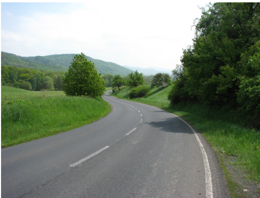
Obrázek 26 - Pohled směr Strážky; levostranný směrový oblouk, který se nachází pod strmým klesáním znázorněným na obrázku č. 17
