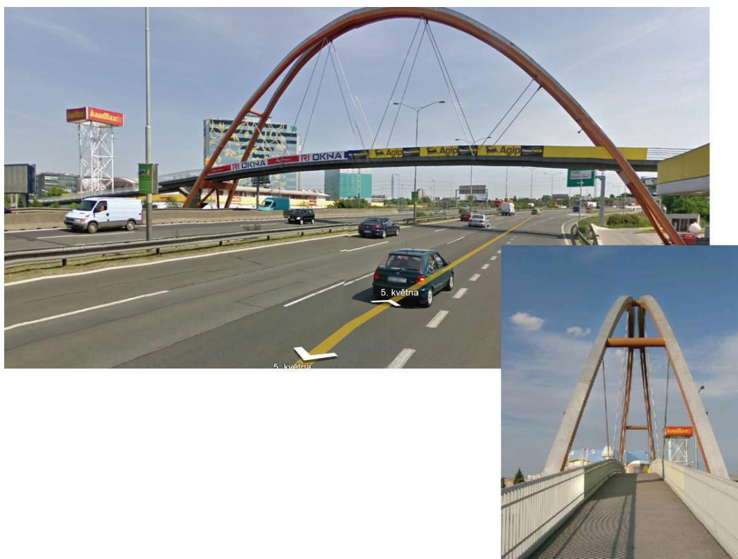
Obrázek 6.3. Pohled na provoz u pěší lávky a na lávku samotnou
