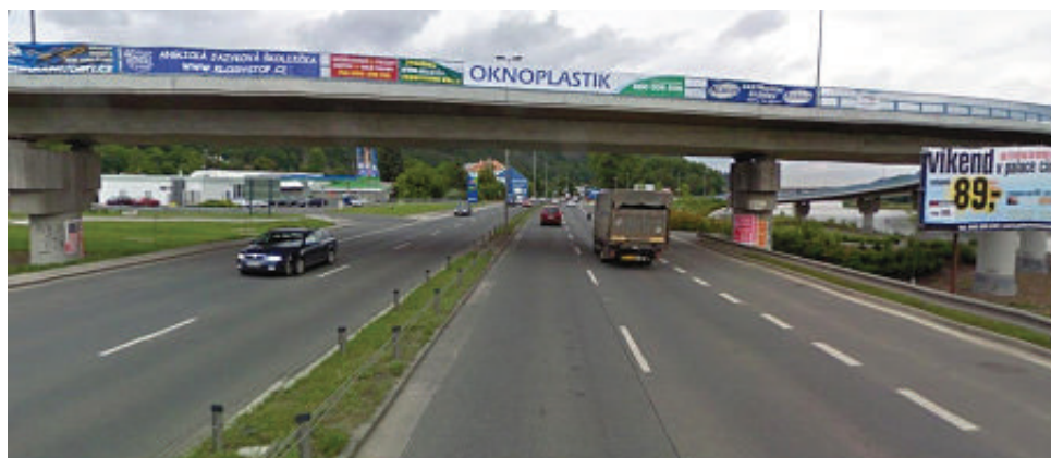
Obrázek 6.8. Mostní nadjezd z pohledu projíždějících vozidel
