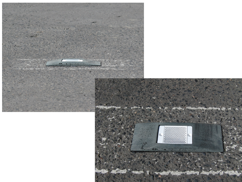
Obrázek 5.6. Ochranné nájezdy s odrazkou přilepené pomocí asfaltové hmoty
