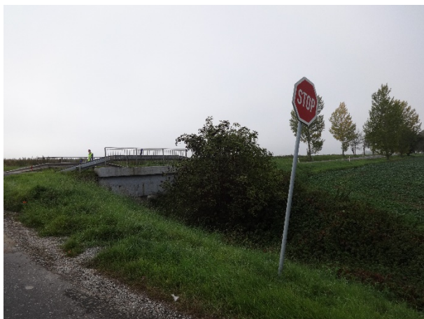
Obrázek 53 – Bližší pohled na neadekvátně ochráněnou hlubinu vzniklou okolním terénem a vedením příčného silničního propustku pod západním ramenem křižovatky (silnice I/16).
