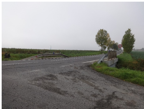
Obrázek 54 – Omezené rozhledové poměry (zábradlí nevhodného stavebního provedení) v místě napojení severního ramene křižovatky (silnice III/23638).
