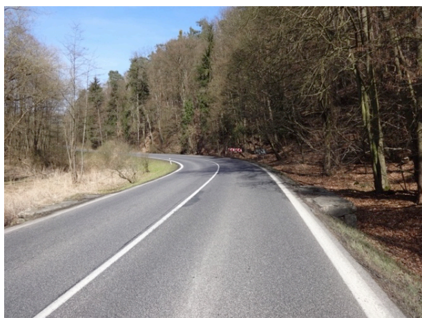
Obrázek 63 – Pohled na levotočivý oblouk (ve směru staničení) malého poloměru silnice I/9. Pevná betonová překážka (na fotografii vpravo).
