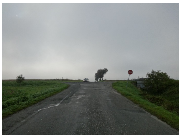
Obrázek 49 – Pohled na sledovanou lokalitu ze severního ramene křižovatky (silnice III/23638).
