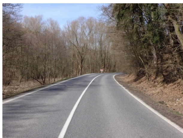
Obrázek 65 – Pohled na pravotočivý oblouk (ve směru staničení) malého poloměru silnice I/9.
