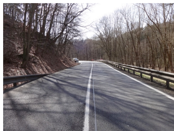
Obrázek 66 – Pohled z opačného směru jízdy na pravotočivý oblouk (ve směru proti staničení) malého poloměru silnice I/9.
