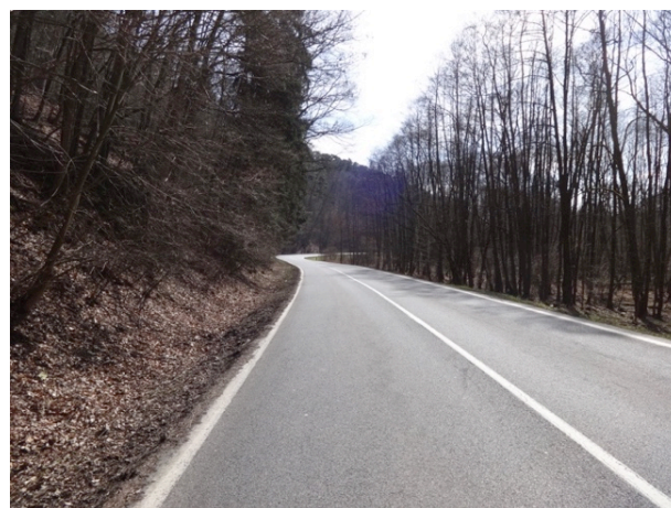
Obrázek 64 – Pohled z opačného směru jízdy na levotočivý oblouk (ve směru proti staničení) malého poloměru silnice I/9.
