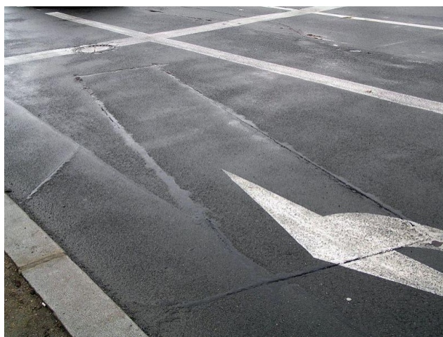
Obrázek 3: Příklad provedení indukční smyčky ve vozovce [5]
