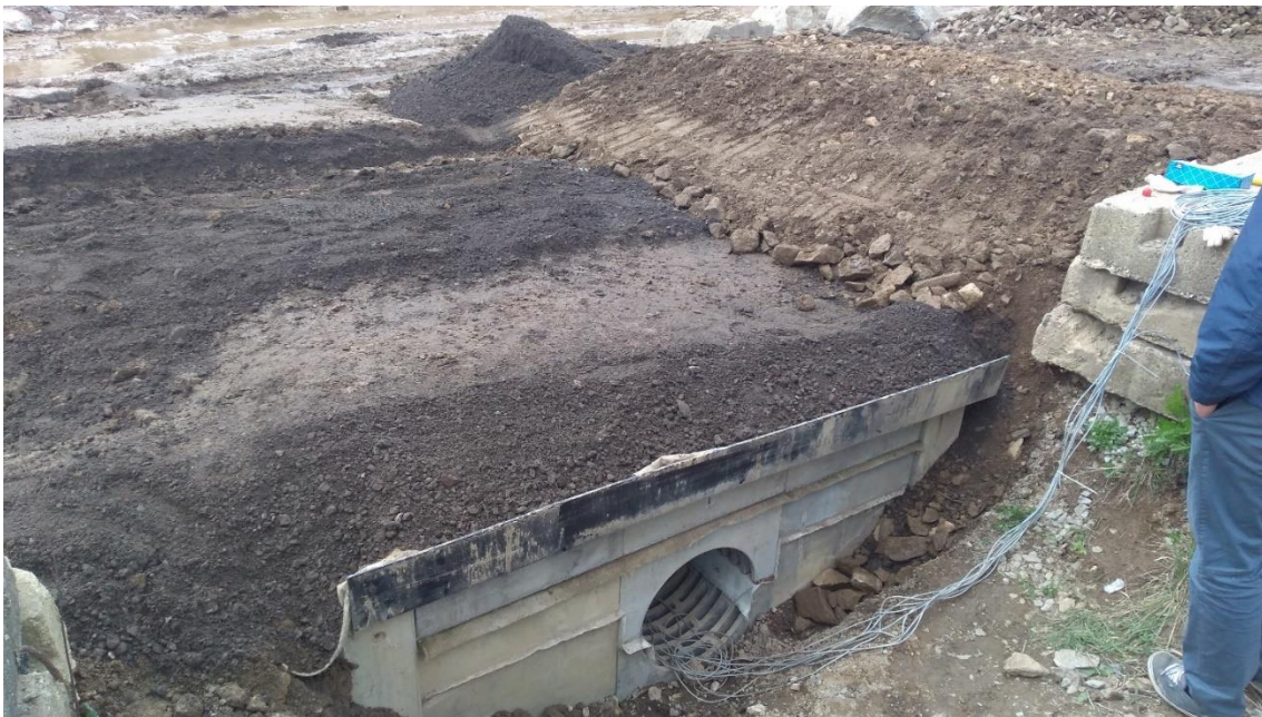
Obrázek 3: Bezpečnostní propustek složený z deformačních bloků a nainstalovaný na testovacím místě. Z otvoru pro průtok vody vedou ven kabely od tenzometrů do měřicí ústředny. Stav těsně před zátěžovými testy 26. dubna 2023.
