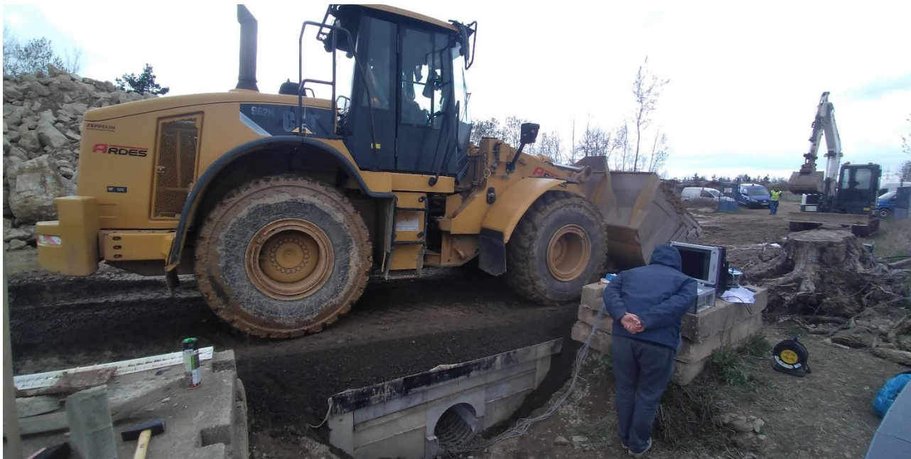
Obrázek 6: Nakladač Caterpillar 962H s plnou lžicí přejíždějící přes testovaný objekt složený z deformačních bloků.
