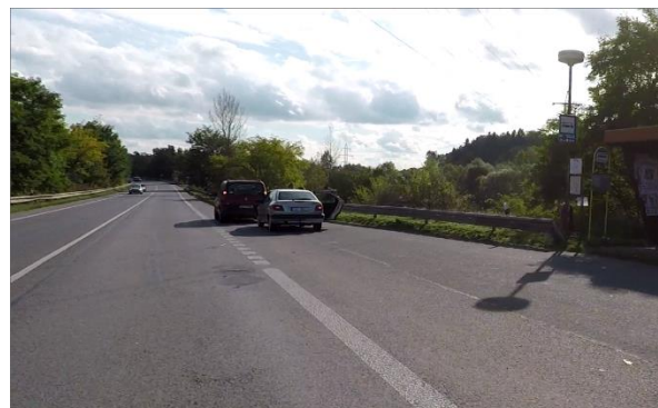
Obrázek 45 – Krátký výškový náběh svodidla – staničení km 30,842 (ID 9570)
