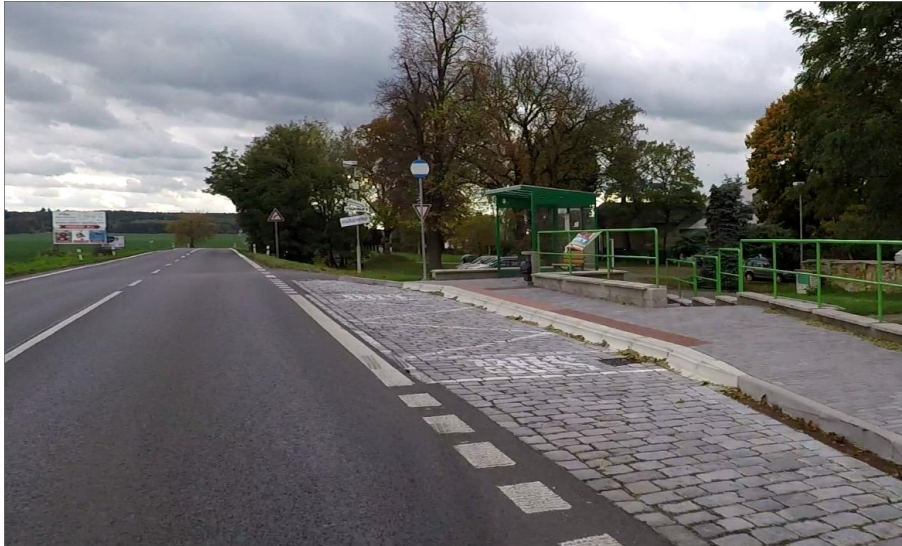
Obrázek 10 – Tzv. kaselský obrubník v obci Bratronice na PK I/38.
