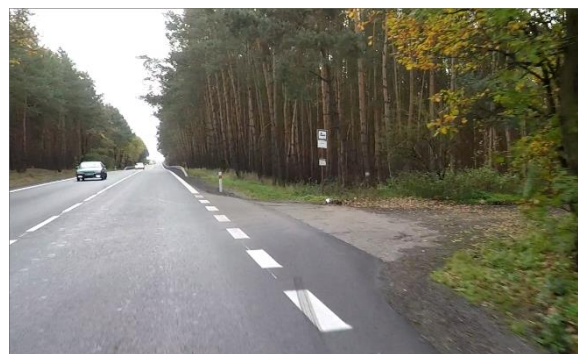
Obrázek 15 – Autobusová zastávka v provozním staničení km 71,613.
