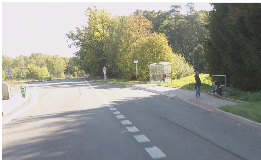
Obrázek 9 – Tzv. kaselský obrubník u obce Staré Splavy na PK I/38.
