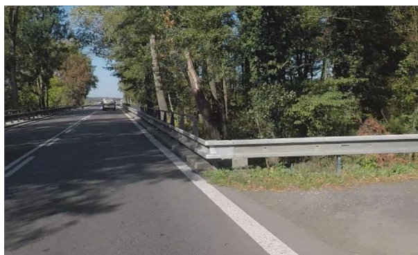
Obrázek 49 – Neadekvátně provedené svodidlo – staničení km 9,207 (ID 304)
