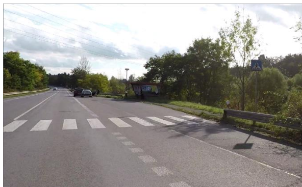
Obrázek 44 – Krátký výškový náběh svodidla – staničení km 30,807 (ID 9565)
