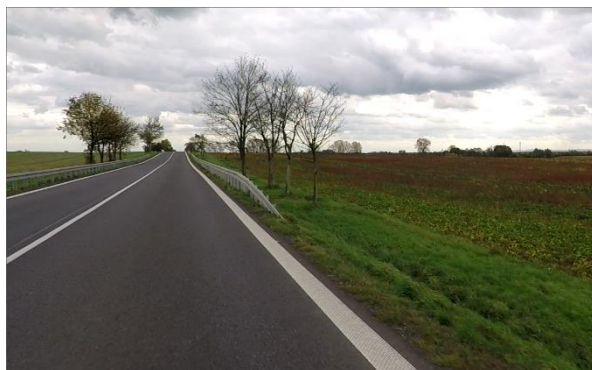
Obrázek 33 – Krátké svodidlo před stromem – staničení km 52,260 (ID 9921)
