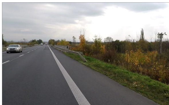
Obrázek 26 – Krátké svodidlo před mostem – staničení km 103,053 (ID 11507)
