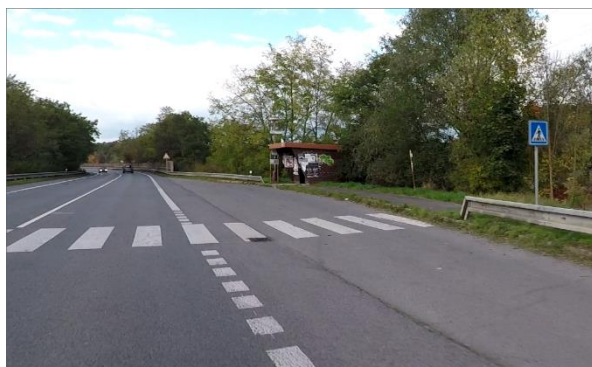
Obrázek 46 – Krátký výškový náběh svodidla – staničení km 30,812 (ID 9625)
