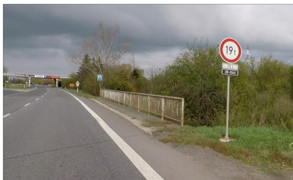
Obrázek 35 – Nevhodný typ zádržného zařízení – staničení km 95,151 (ID 12411)
