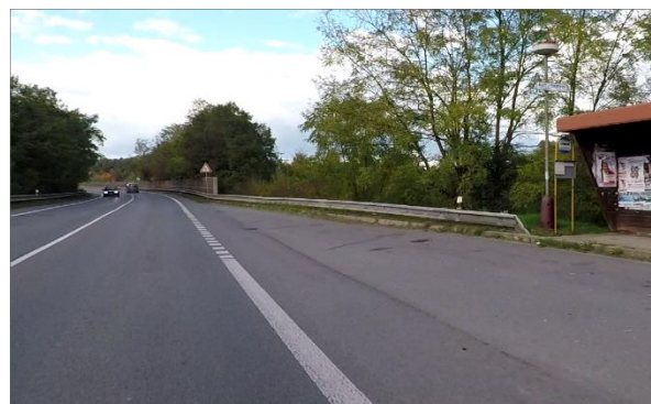
Obrázek 47 – Krátký výškový náběh svodidla – staničení km 30,783 (ID 9626)
