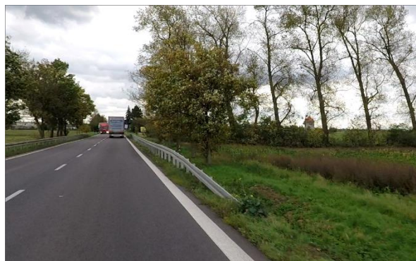
Obrázek 34 – Krátké svodidlo před stromem – staničení km 53,139 (ID 9929)
